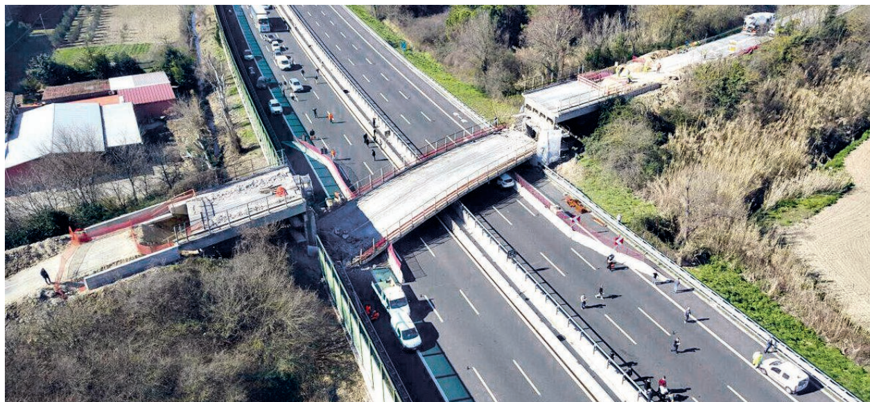
Un'immagine aerea del cavalcavia crollato sulla A14
